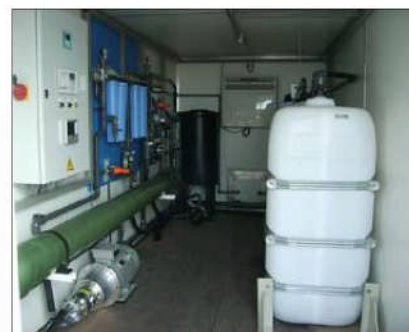
Planta piloto de ósmosis inversa
